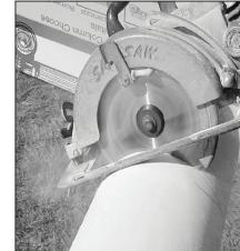
2. Use una sierra abrasiva (para manpostería o de hoja de Carburo) para emparejar la parte superior e inferior y asegurar un buen contacto con la superficie.
