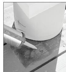
5. Aplique adhesivo de construcción de la misma forma en que aplicaría una masilla, alrededor del eje de la columna donde entra en contacto con el piso y la viga. Use su dedo para presionar / aplastar el cordón de adhesivo en contacto con esas superficies.
