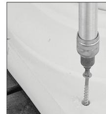
8. Aplique el pegamento a la parte inferior de la Base. Asegure con tornillos o clavos.
