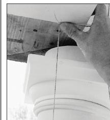
4. Aplice la columna. Asegúrese que la carga esté distribuida y centrada uniformemente alrededor de la superficie portante.
